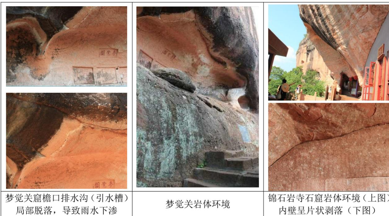
梦觉关石窟檐口排水沟（引水槽）局部脱落，导致雨水下渗
