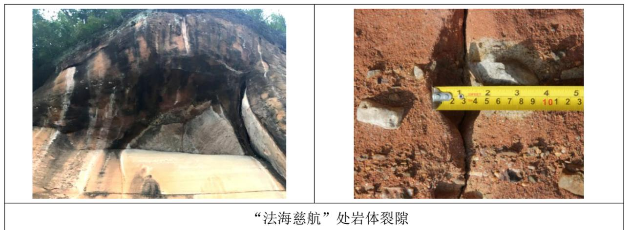
对于“法海慈航”的裂隙还伴随着基岩裂隙水的病害类型, 建议建立专项研究, 查明渗水根源, 提出切实有效的治理方案。
