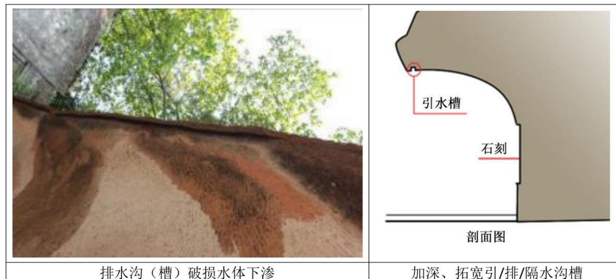
针对别传寺老山门前阶梯左侧的排水沟（引水槽）局部脱落，导致雨水下渗到石刻的问题，首先在崖顶设挡水坝或截水沟，其次加深、拓宽排水沟（引水槽）的深度和宽度，引水沟做防渗处理，引水沟贯穿整个崖壁。
