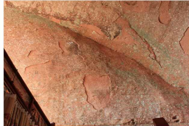
层片状、鳞片状剥落害类型的保护措施
